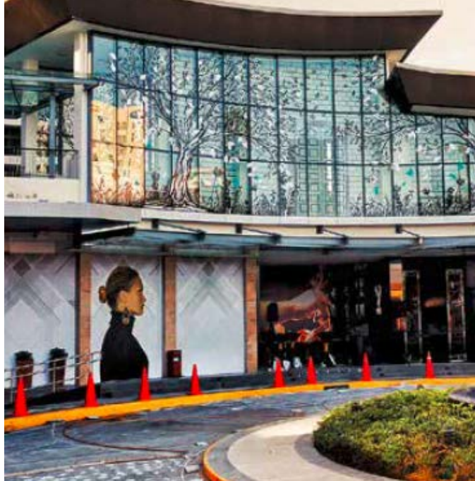
Imagem: Cortesia da H.S. Pow Construction and Development Corporation
